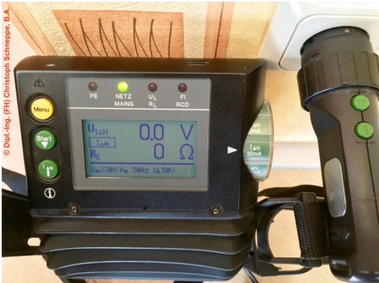
Messung der Berührungsspannung an einem Steckdosenstromkreis mit Fehlerstrom-Schutzeinrichtung (RCD)
