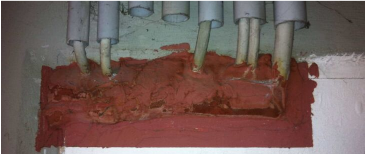
Deckendurchbruch mit Leitungsbündel (Bildquelle: Dr.-Ing. Jens Jühling)
